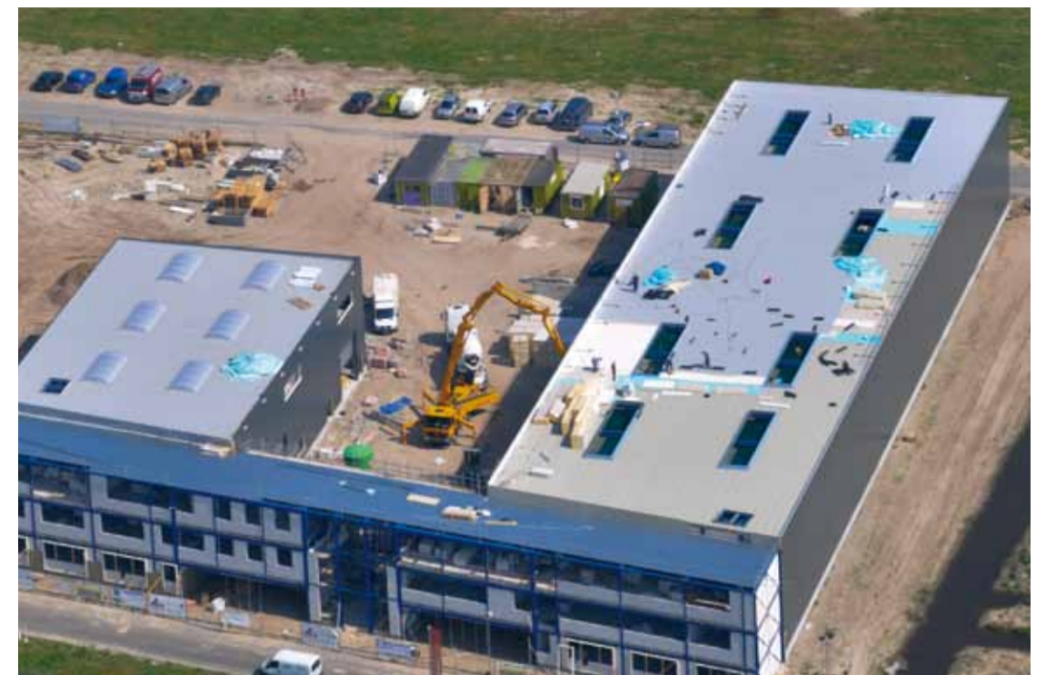
Albers Zeilmakerij, Boilerstraat 40 EDE
